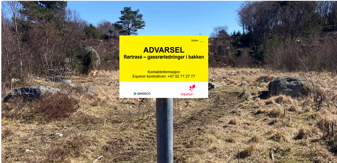
Merking langs rørledningstraséen.
