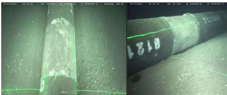
Figur 6-8: Feltskjøt med oppfyllingsmateriale av polyuretan iblandet grus. Finnes mellom Valemon og Huldra (KP0-KP27).
