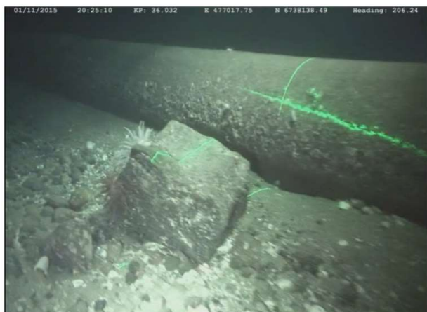
Figur 7-7: Eksempel på stein som må fjernes før grøfting.
