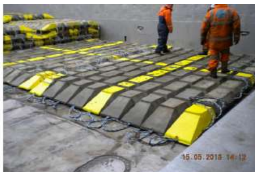
Bilde fra produksjon av betongmattene
